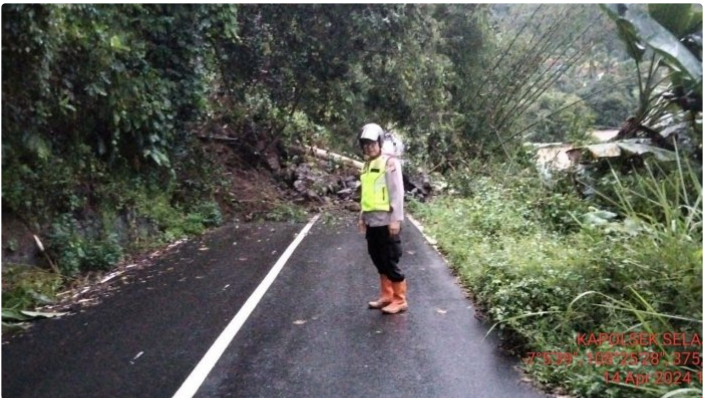
Akses jalan dari Selajambe menuju Darma kembali tertutup Longsor
